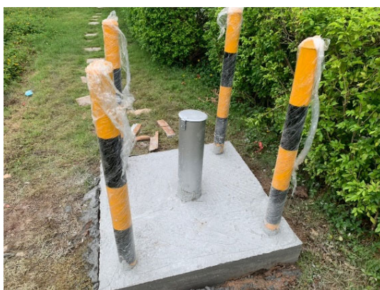
รูปแสดงการติดตั้ง Inclinator
