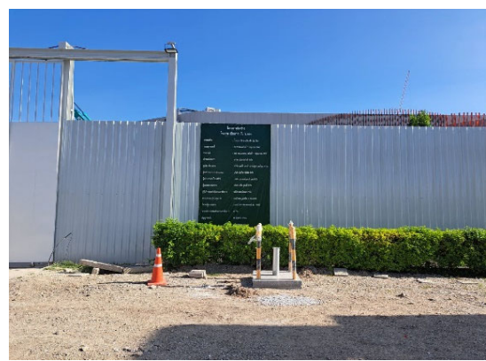
รูปแสดงการติดตั้ง Inclinator
